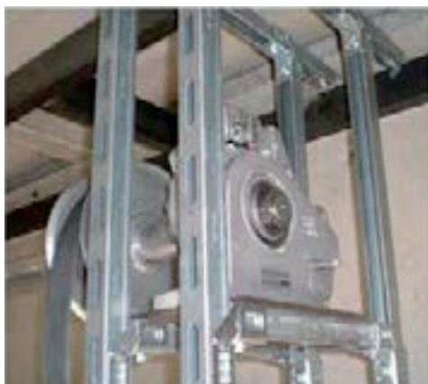
Particolare del sistema anticaduta e della struttura portante con profili Hilti
